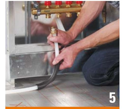
*So sind auch große Flächen rationell und schnell verlegt. Als Heizestrich können alle heute im Einsatz befindlichen Arten verwendet werden, z. B. die selbstnivellierenden Anhydrit-Fließestriche.*
