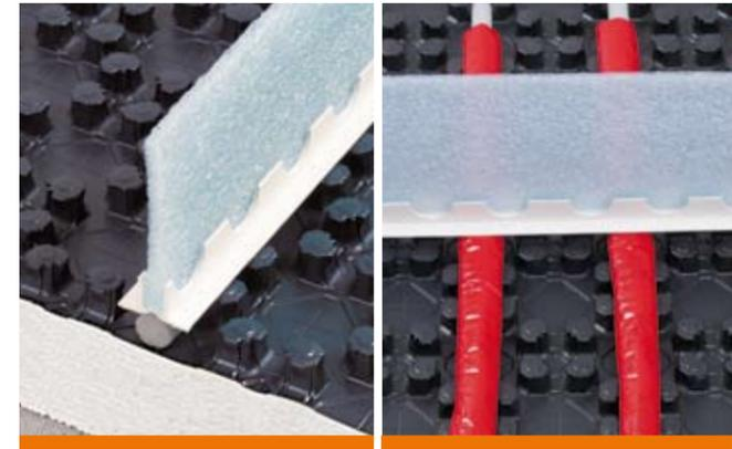
>> Vor- und Rücklauf im Bereich der Bewegungsfuge mit dem Schutzrohr versehen.
