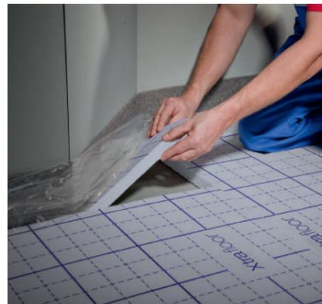
Einfacher Zuschnitt von Passstücken und minimaler Verschnitt durch Verarbeitung von Reststücken. Estrichdichte Plattenverbindung bei Reststücken ohne Überlappung durch XtraFloor Klebeband herstellbar.
